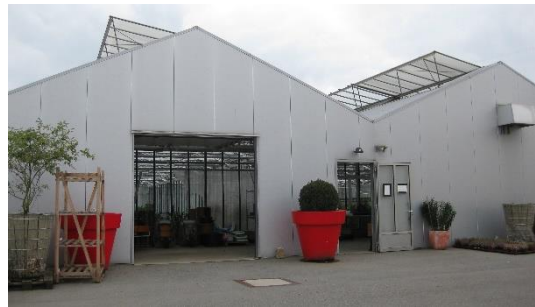
Stadtgärtnerei Amberg, Eingang zu den Gewächshäusern
