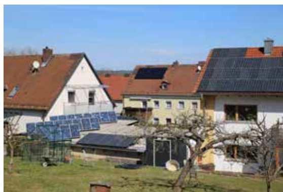
Abbildung 42: Nutzung von Solarenergie
