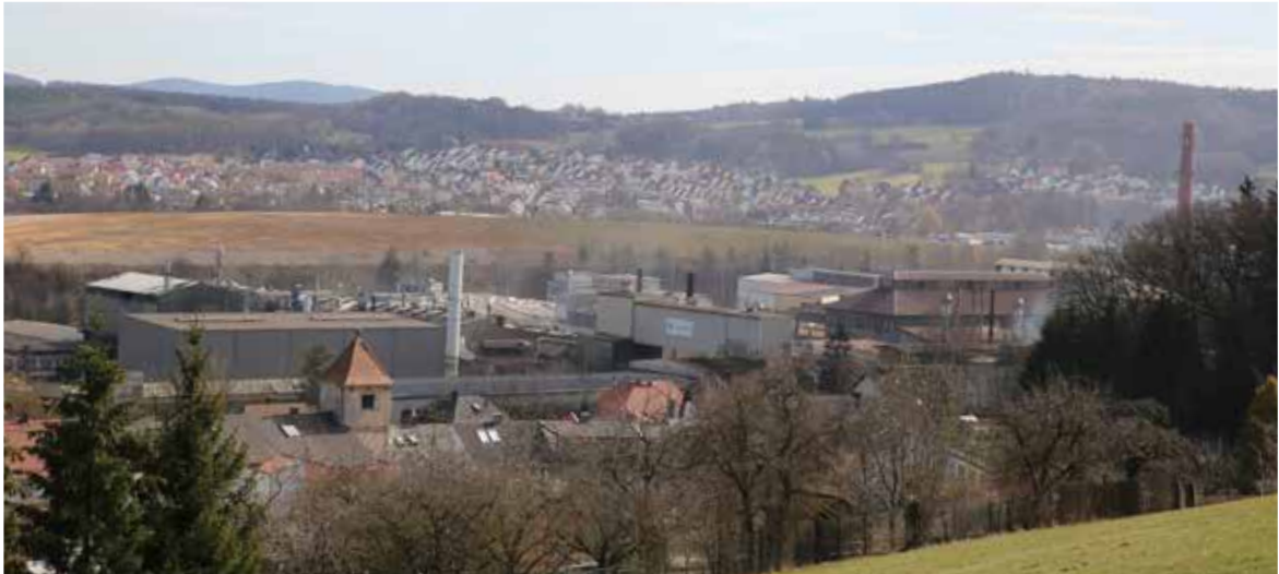
Abbildung 26: Blick auf die Luitpoldhütte
