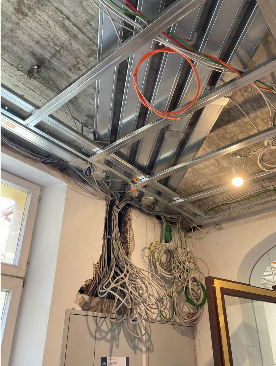
Um die Brandlasten aus den Zwischenecken der notwendigen Flure zu reduzieren, müssen sämtliche Installationsleitungen, die nicht für die Versorgung der Flure notwendig sind, in Brandschutzkanäle verlegt werden.
