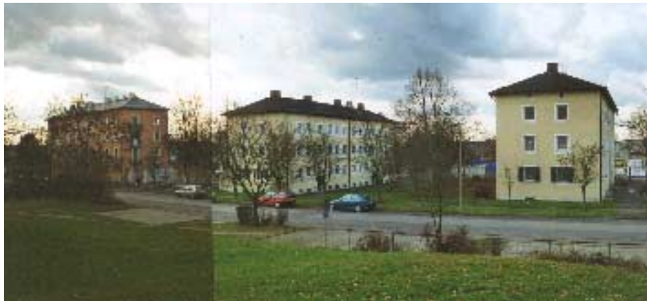
Wohnblöcke Rosenthalstraße 2 - 4, Gerresheimer Straße 16 - 22
