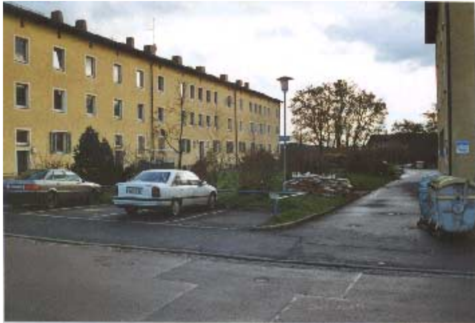
Wirtschaftshof an der Breslauer Straße mit Müllcontainer, Sperrmülllager und Parknutzung an den Stirnseiten und auch direkt vor den Gebäuden.
