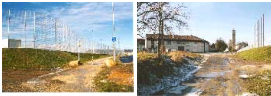
Mangelhaft Eingrünung des Sportplatzes
