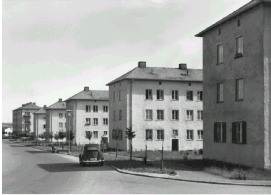
Wohnbebauung Gerresheimer Straße
