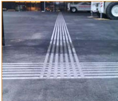
Orientierungs-Leitlinien werden aus vorhanden Betonplatten ausgefräst
