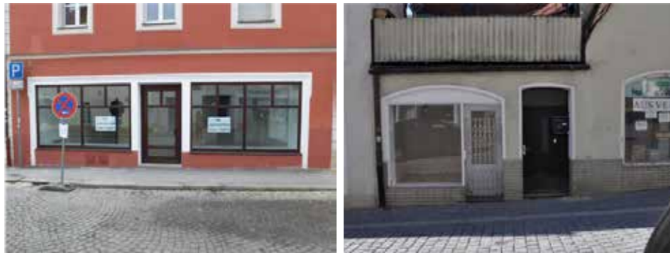
Abb. 60: Leerstandssituationen in der 1b- und 1c-Lage in Amberg, (Aufnahme von ISR, 2017)
