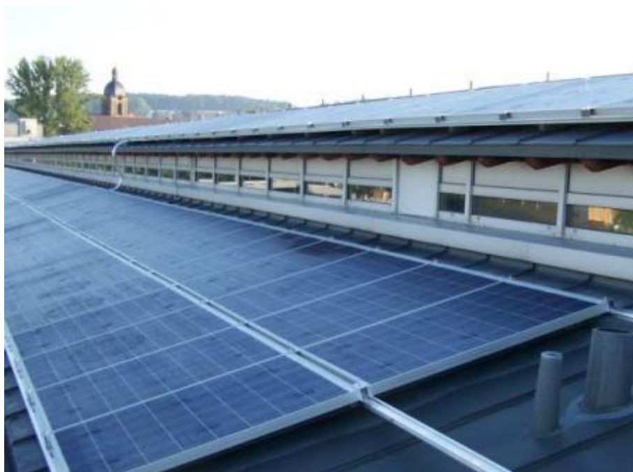
Abbildung 13: Installation einer Photovoltaikanlage auf dem Werkstattgebäude (134 kW p )
