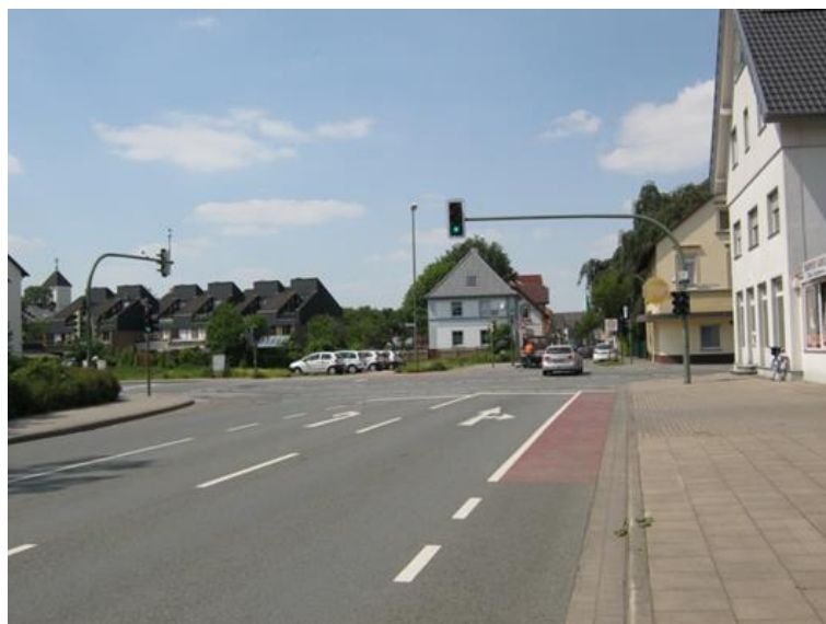
Abb. 4-13: Vorbeifahrstreifen in einer signalisierten Knotenpunktzufahrt (Bielefeld).
