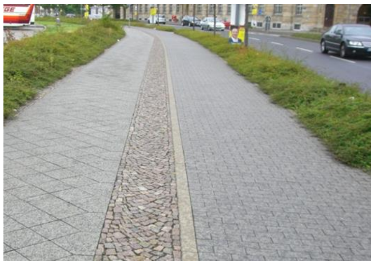
Abb. 4-1: Vom Gehweg getrennter Radweg (Beispiel Leipzig).
