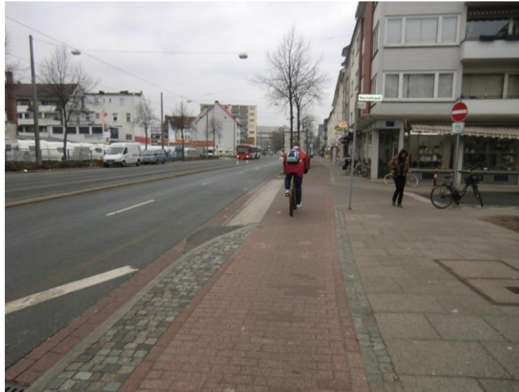
Abb. 4-11: Teilaufpflasterung im Einmündungsbereich einer Nebenstraße (Bremen).
