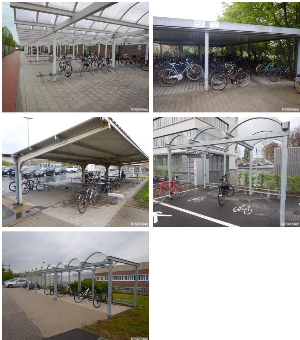
Abb. 9-3: Abstellanlagen rund um das Siemensgelände in Amberg. Bei der Besichtigung vor Ort wurden fünf verschiedene Anlagen betrachtet.
