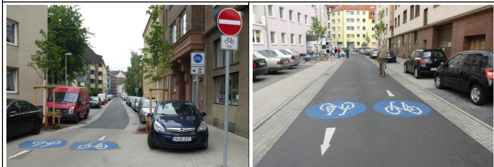
Beispiel Hannover Runde Piktogramme in Blau und Richtungspfeile im Straßenverlauf. Die Rinnen zwischen der asphaltierten Fahrbahn und den Parkständen sind farblich abgesetzt gepflastert und dienen als Sicherheitstrennstreifen.
